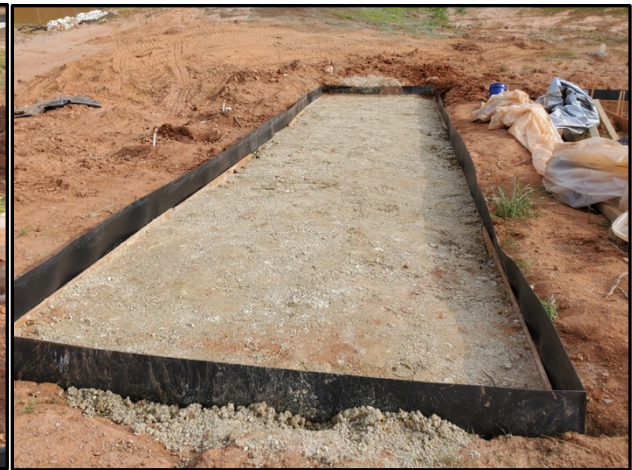
(d) Compaction after first lift
