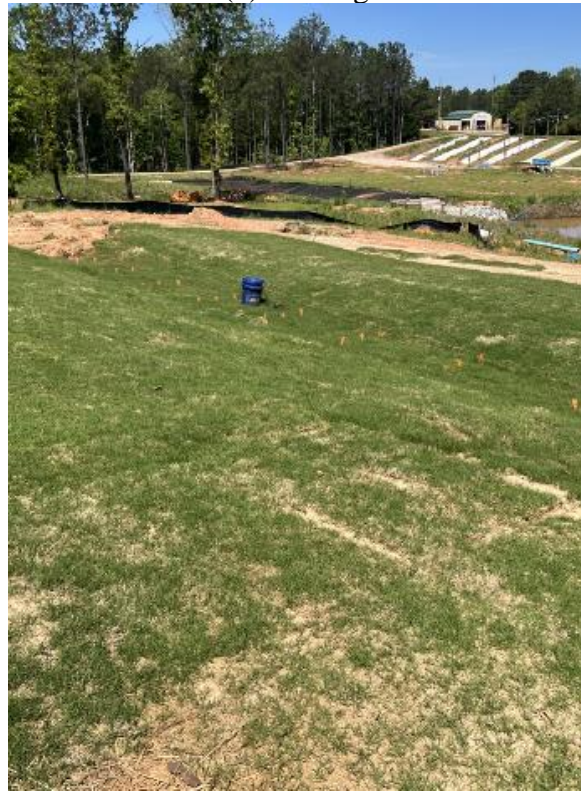
(d) stabilized sod
