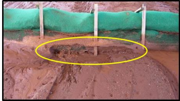
(d) undermining – pyramid installation
