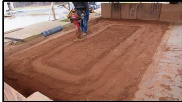
(d) jumping jack compaction plate
