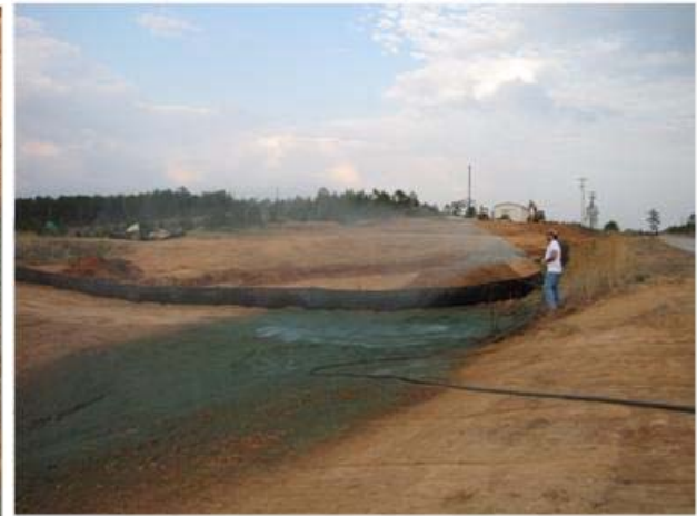
(d) hydromulch application and silt fence
