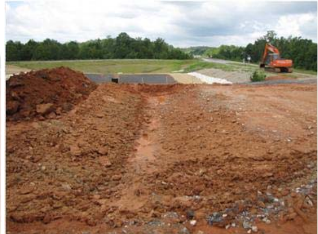
(d) rough excavation of the right test channel
