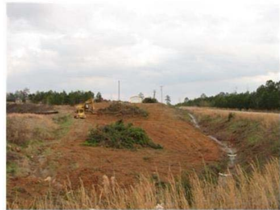
(d) completion of clearing and grubbing
