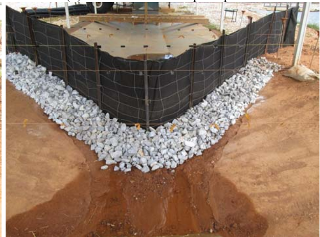
(d) modified no. 4 stone dissipater post test
