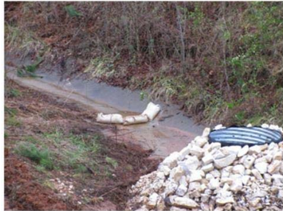
(d) sand bag ditch checks
