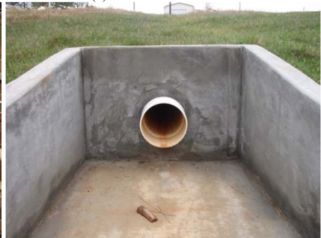
(d) constructed discharge area
