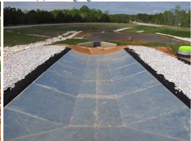
(d) construction final
