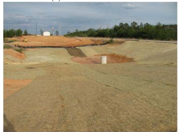
(d) complete stabilization of pond banks
