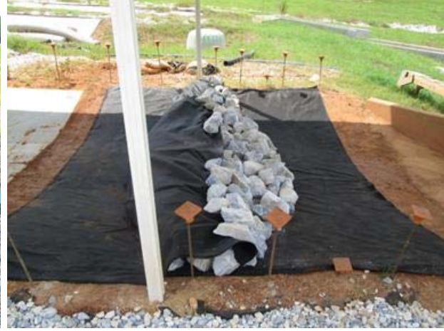
(d) 8 oz. FF choker secured w/riprap
