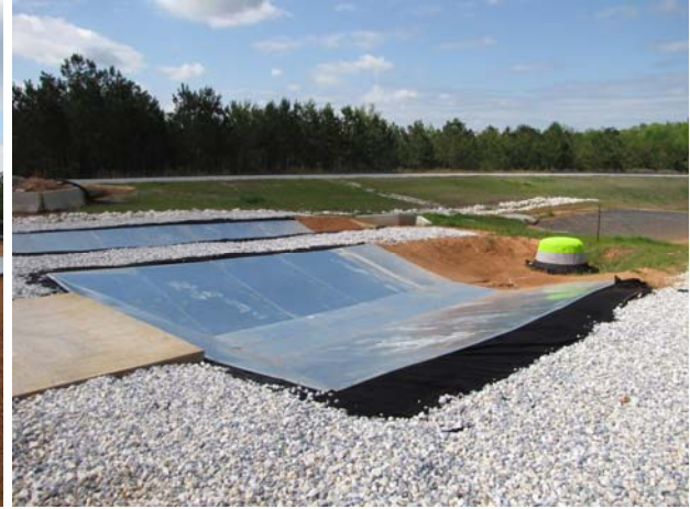
(d) construction final
