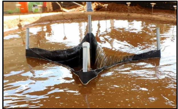
(d) Fence Post Installation
