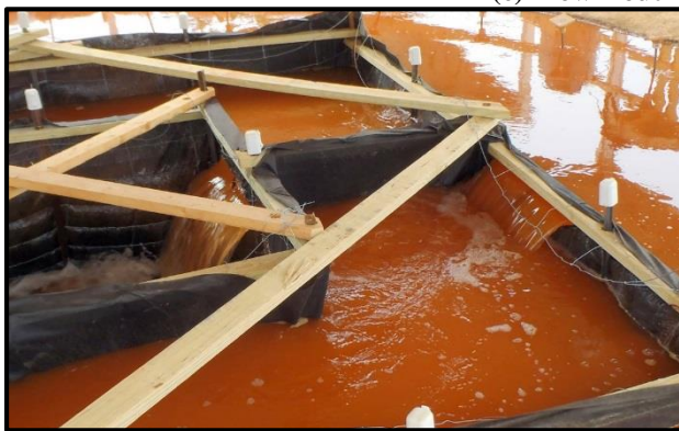
(d) Weirs Under Full Impoundment
