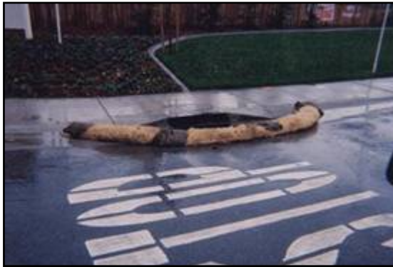
a. Inlet Protection
