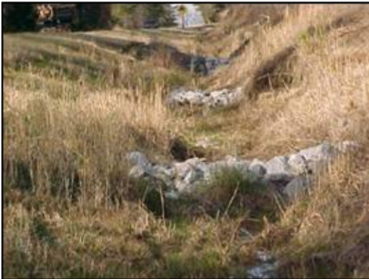
a. Rip Rap Ditch Check
