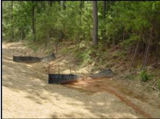
b. Ditch Check
