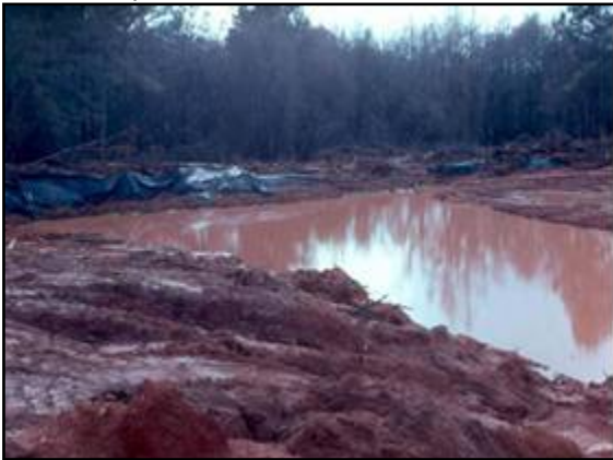
a. Sediment Basin
