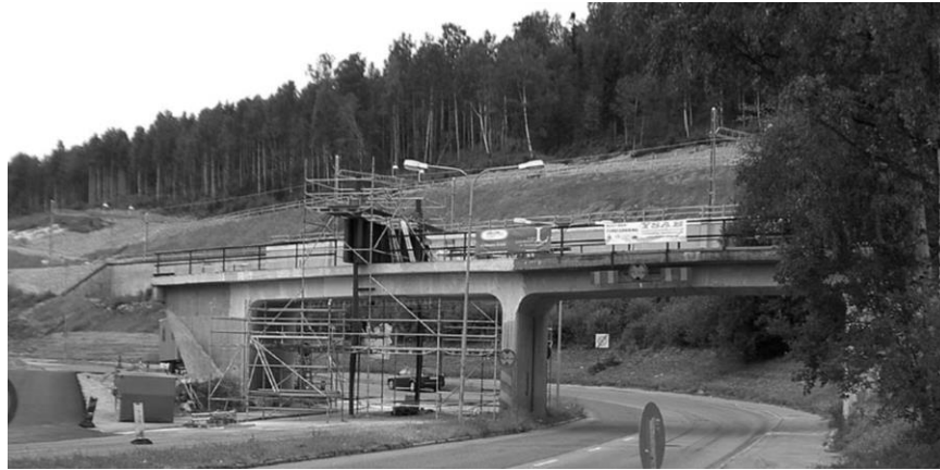
Figure 2.17 Örnsköldsvik Bridge (Bergström, Täljsten, and Carolin 2009)
