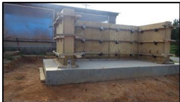
(d) formwork for retaining wall
