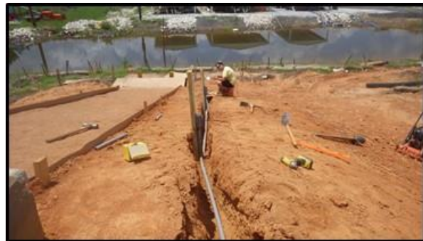
(d) installation of PVC conduit
