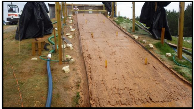
(d) slope erosion after interval 3
