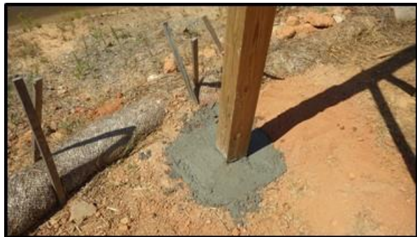
(d) post set in poured concrete
