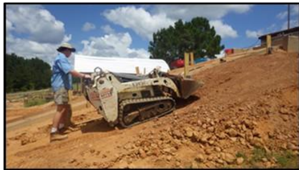
(d) compaction of slope with a bobcat
