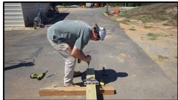
(d) installing eye bolts into support posts
