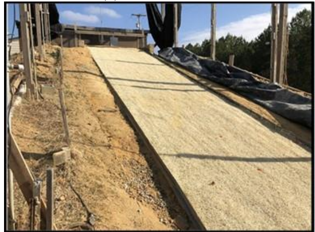
(d) Installed ECB
