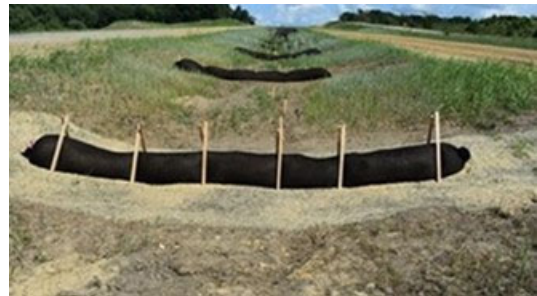
(d) W-M field installation
